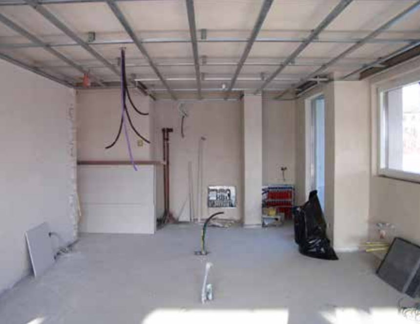
1- RILIEVO FOTOGRAFICO CANTIERE _ PHOTOGRAPHIC RELIEF OF BUILDING SITE
